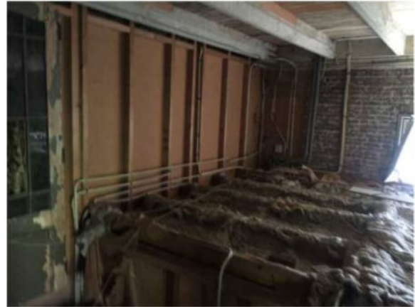
Foto's van de ruimte boven de plafonds begane grond opgebouwd uit houten ribben en plaatmateriaal
