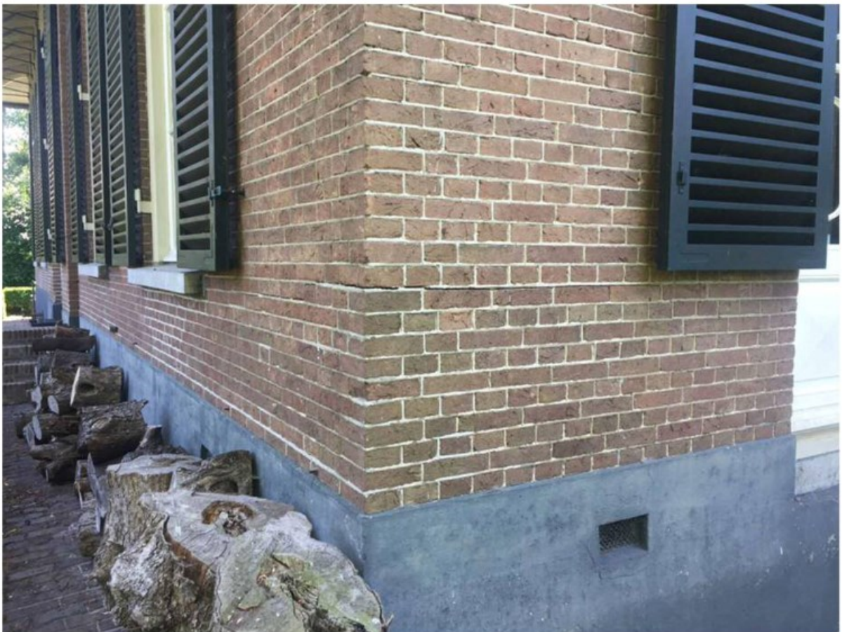
Foto's van de huidige staat van het metselwerk, de plint en de overstek ankers
