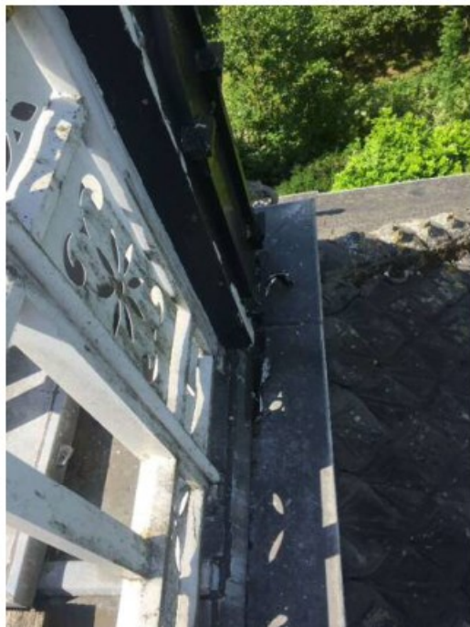
Foto's van de balustrade van de belvédère met de aansluiting baluster op de zinken dakbedekking
