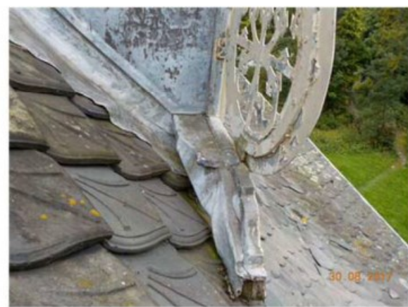
Foto's van de dakdekking en onderlinge aansluitingen ter plaatse van de dakknik, breuklijst en dakkapellen
