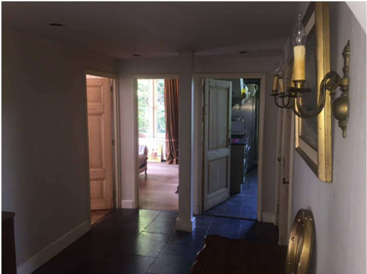
Foto van de geplaatste binnenwanden en plafonds in voormalige speelzaal
