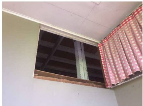
Foto links verzwaaarde onderslagbalk woonkamer Foto rechts doorgaande staander tussen ruimte plafond en verdiepingsvloer
