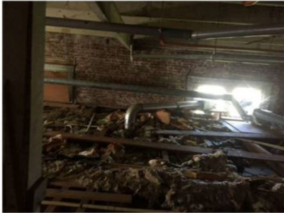
Foto's van de ruimte boven de plafonds begane grond opgebouwd uit houten ribben en plaatmateriaal
