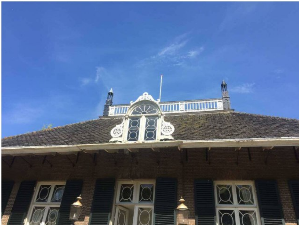
Foto van de ornamentering van de dakkapel
