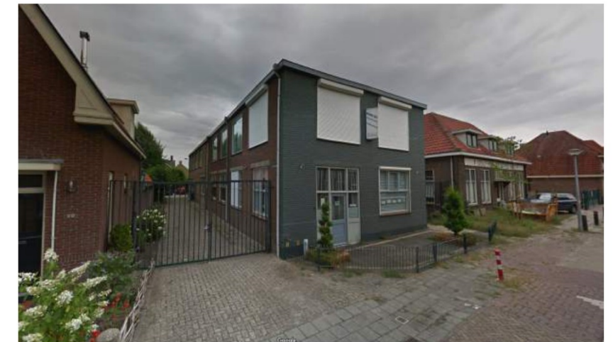
03. KOPGEVEL EN NOORDGEVEL MEUBELSTOFFEERDERIJ
